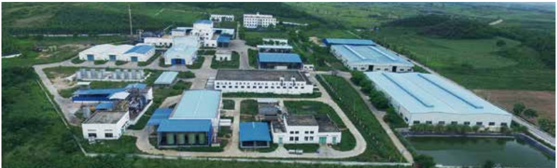
Hainan Hazardous Waste Disposal Center Plant 海南省危險廢物處置中心廠區
