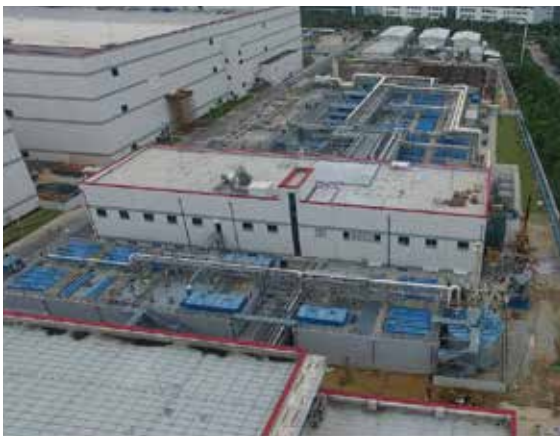
LG Display's Wastewater Treatment Project 樂金顯示公司廢水處理工程
