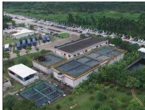
Wuyang-Honda Motorcycle's Wastewater Treatment Project 五羊-本田摩托公司污水處理工程
